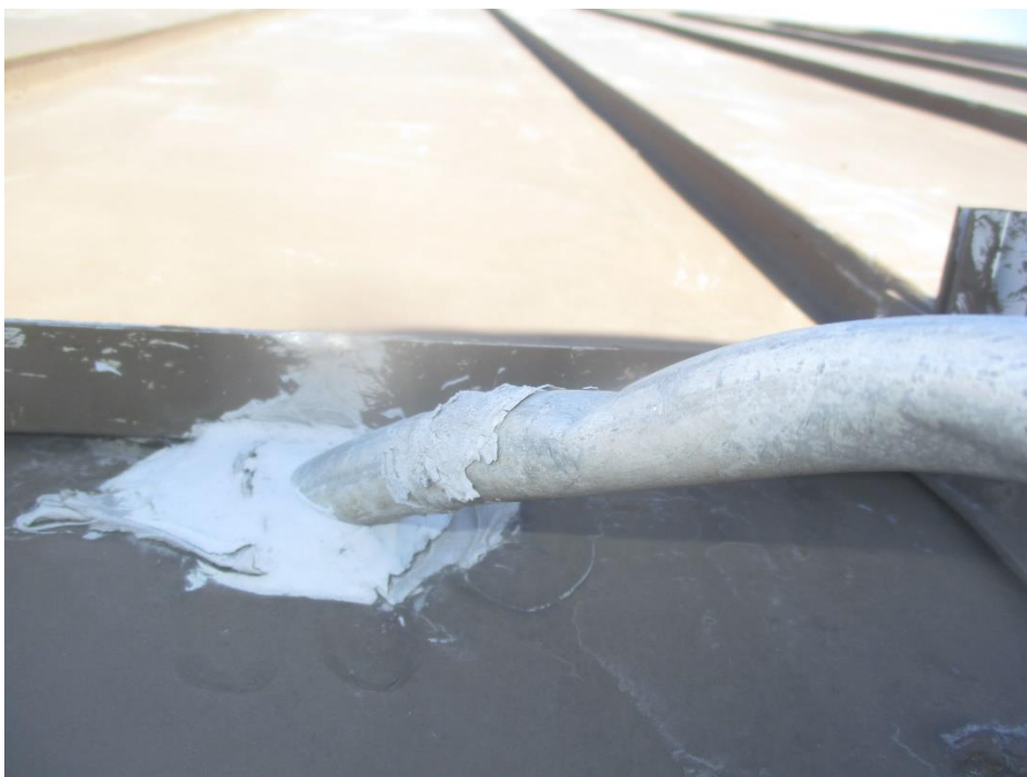
Bild 5: Rör genomföring på vattentak
