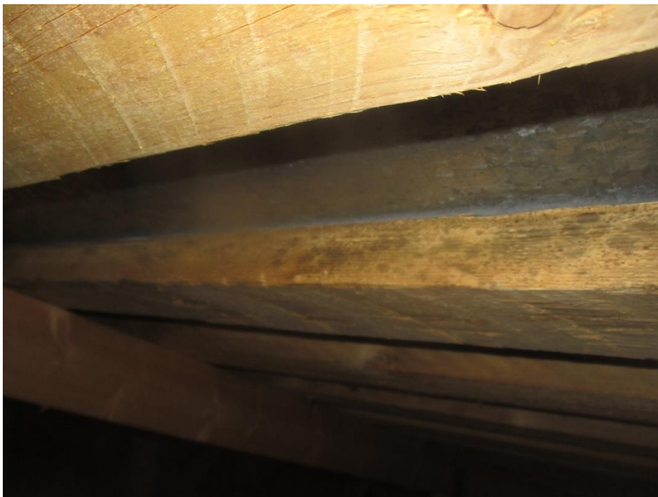
Bild 9: Missfärgningar på glesbrädningen
