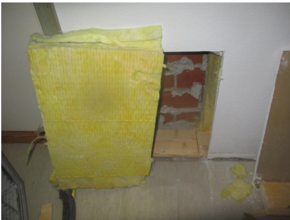
Bild 22: Håltagning i yttervägg, 146 Kafferum
