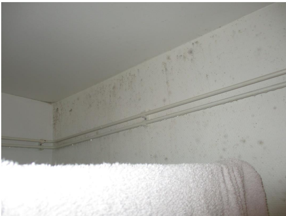
Bild 1: Mikrobangripen badrumsvägg i lägenheten
