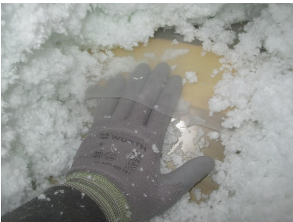
Bild 8: Otejpad ångspärrsskarv
