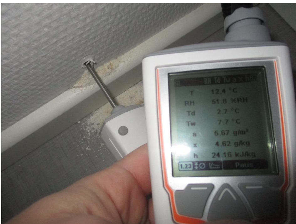
Bild 26: Fuktmätning i ytterväggens isoleringsskikt
