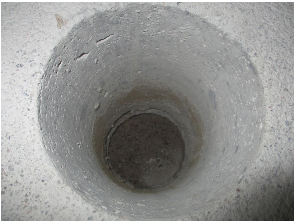
Bild 19: Håltagning i golvbjälklag
