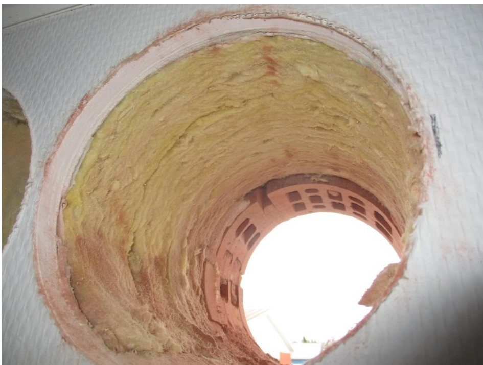
Bild 21: Håltagning i yttervägg
