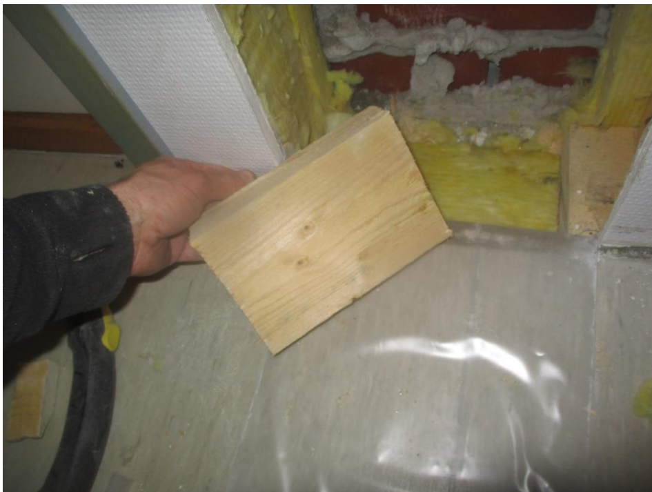
Bild 23: Håltagning i yttervägg, syllen
