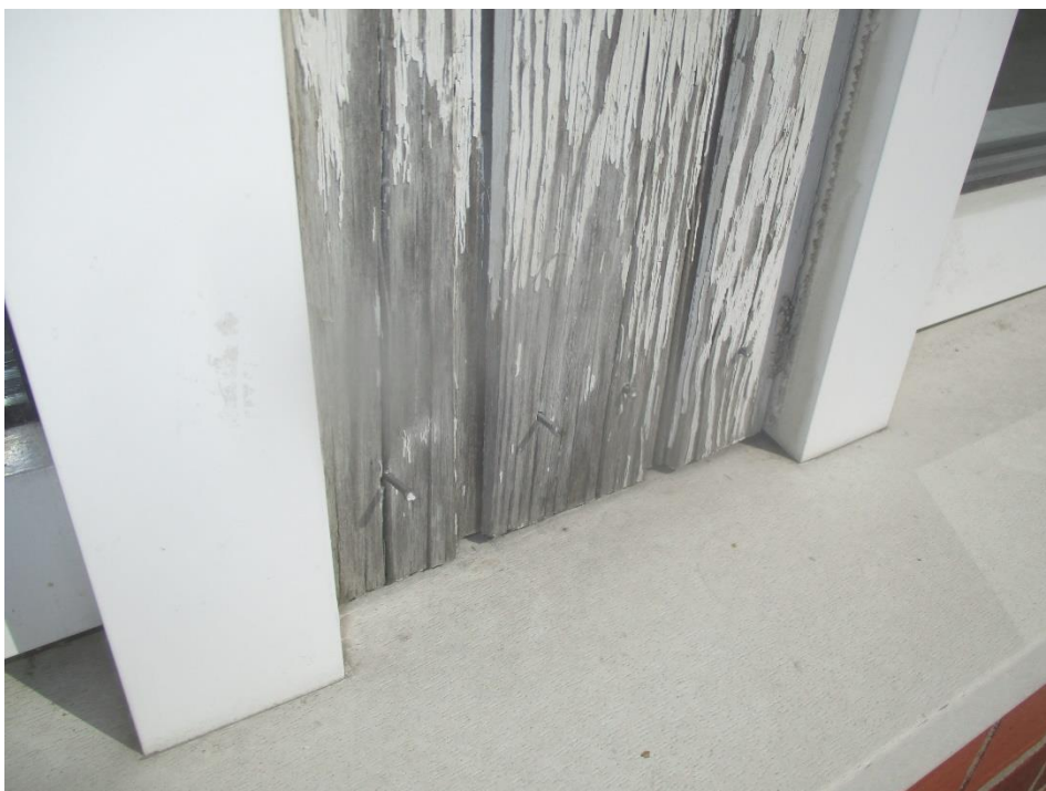
Bild 12: Murken träpanel mellan fönster
