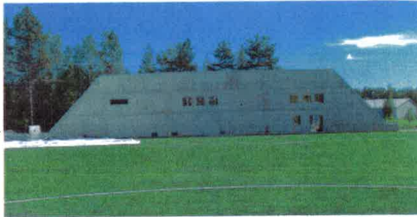
Bild 1.4. Betongvägg förberedd som fasad inifrån hallen till sociala utrymmen.
