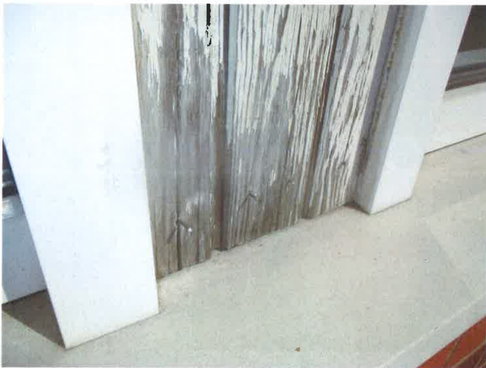
Bild 12: Murken träpanel mellan fönster
