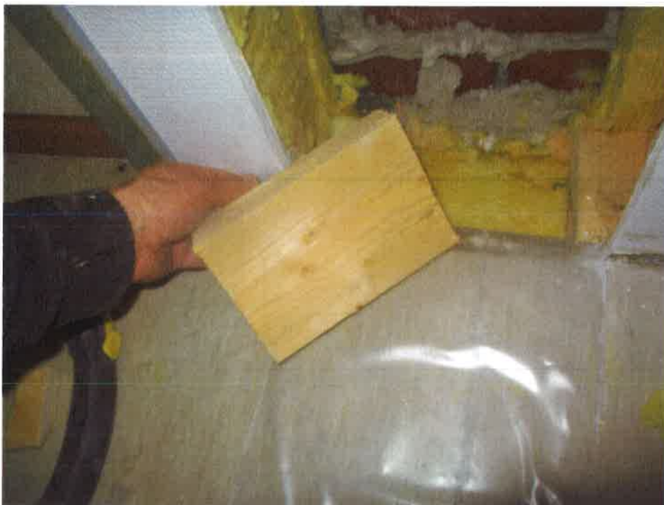
Bild 23: Håltagning i yttervägg, syllen
