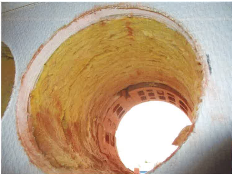
Bild 21: Håltagning i yttervägg
