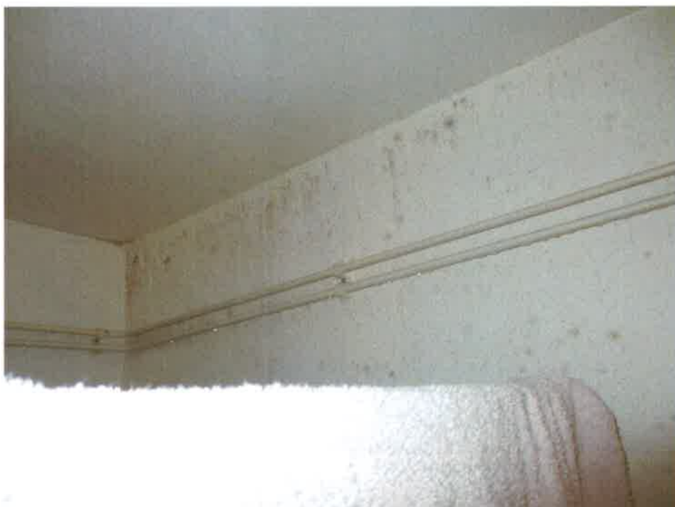
Bild 1: Mikrobangripen badrumsvägg i lägenheten
