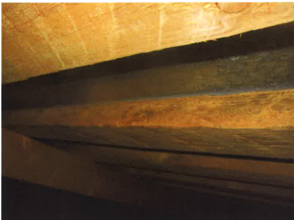
Bild 9: Missfärgningar på glesbrädningen
