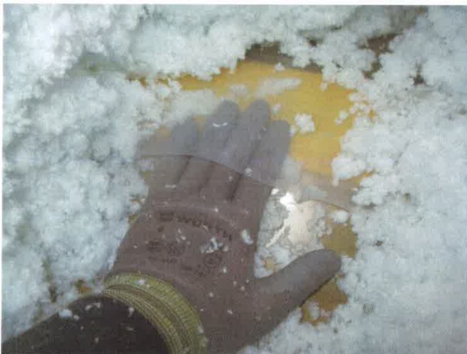
Bild 8: Otejpad ångspärrsskarv
