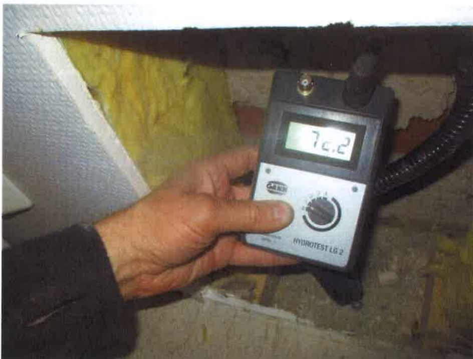
Bild 24: Håltagning i yttervägg, fuktmätning på sockel
