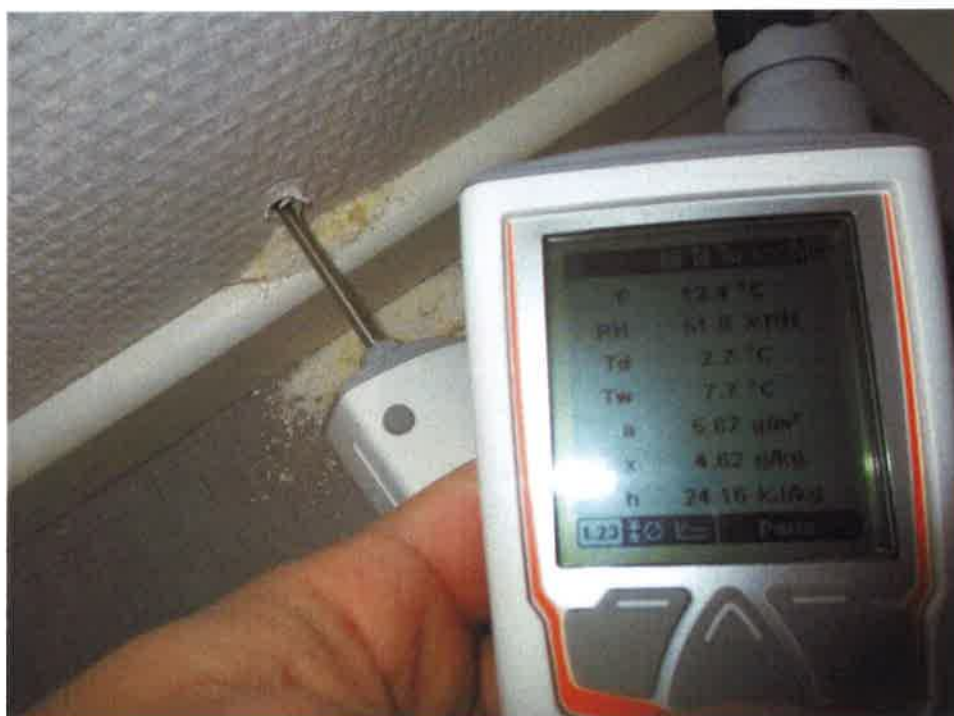
Bild 26: Fuktmätning i ytterväggens isoleringsskikt
