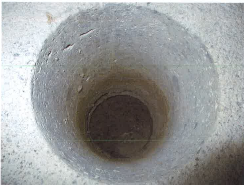
Bild 19: Håltagning i golvbjälklag
