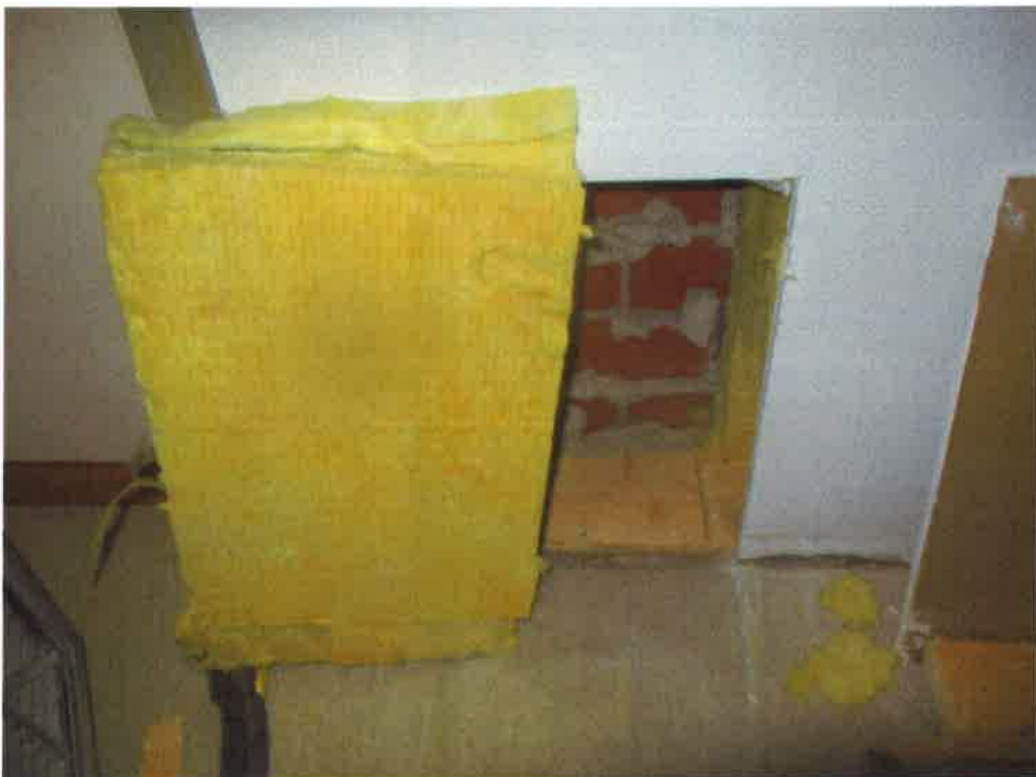
Bild 22: Håltagning i yttervägg, 146 Kafferum
