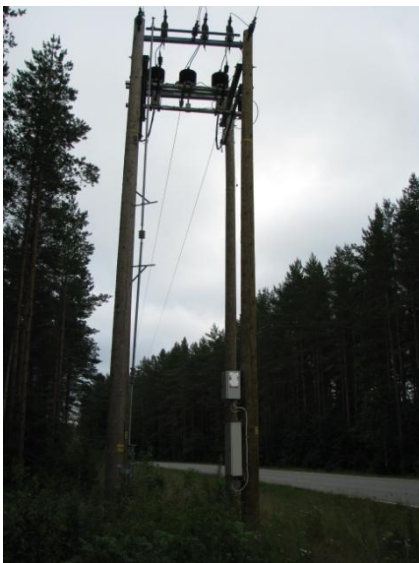
Kuva 38 a, b ja c. Erilaisia muuntamotyyppejä. a) Pylväsmuuntamo Gunnarskanganilla b) tornimuuntamo Bredskärillä ja c) puistomuuntamo Gunnarskanganilla. (Erika Liesegang 19.7. ja 2.8.2012)
