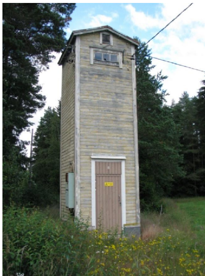
Kuva 38 a, b ja c. Erilaisia muuntamotyyppejä. a) Pylväsmuuntamo Gunnarskanganilla b) tornimuuntamo Bredskärillä ja c) puistomuuntamo Gunnarskanganilla. (Erika Liesegang 19.7. ja 2.8.2012)
