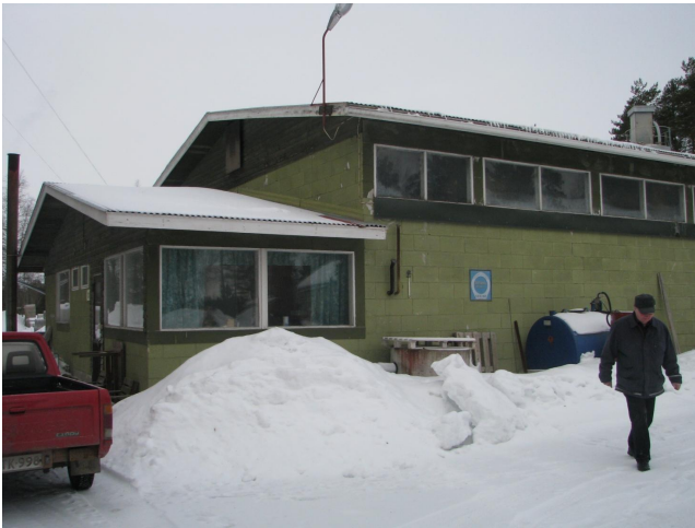
Kuva 33. Valimorakennuksen seinustalla on suoja-altaassa oleva öljysäiliö. (Erika Liesegang 19.3.2013)
