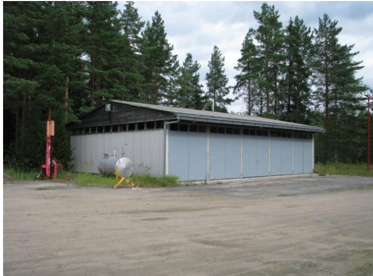
Kuva 37 a ja b. Tielaitoksen entinen tukikohta Härmäläbackenilla. a) Entinen polttonesteen jakelupumppu b) Halli ja öljysäiliö. (Erika Liesegang 31.7.2012)
