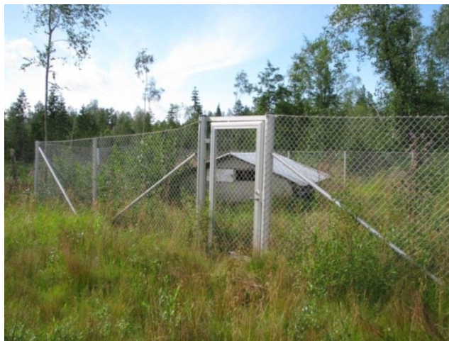
Kuva 8. Värmgjutkällanin vedenottamo (Erika Liesegang, 1.8.2012)
