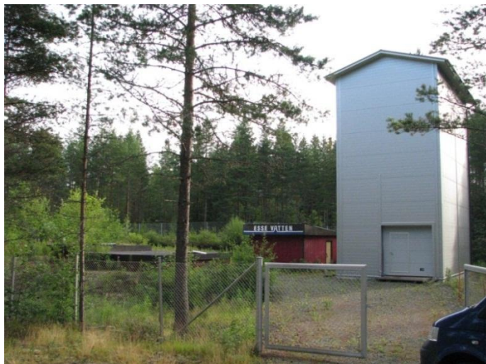
Kuva 9. Vannabban vedenottamo sijaitsee aidatulla ja lukitulla alueella. (Erika Liesegang, 1.8.2012)
