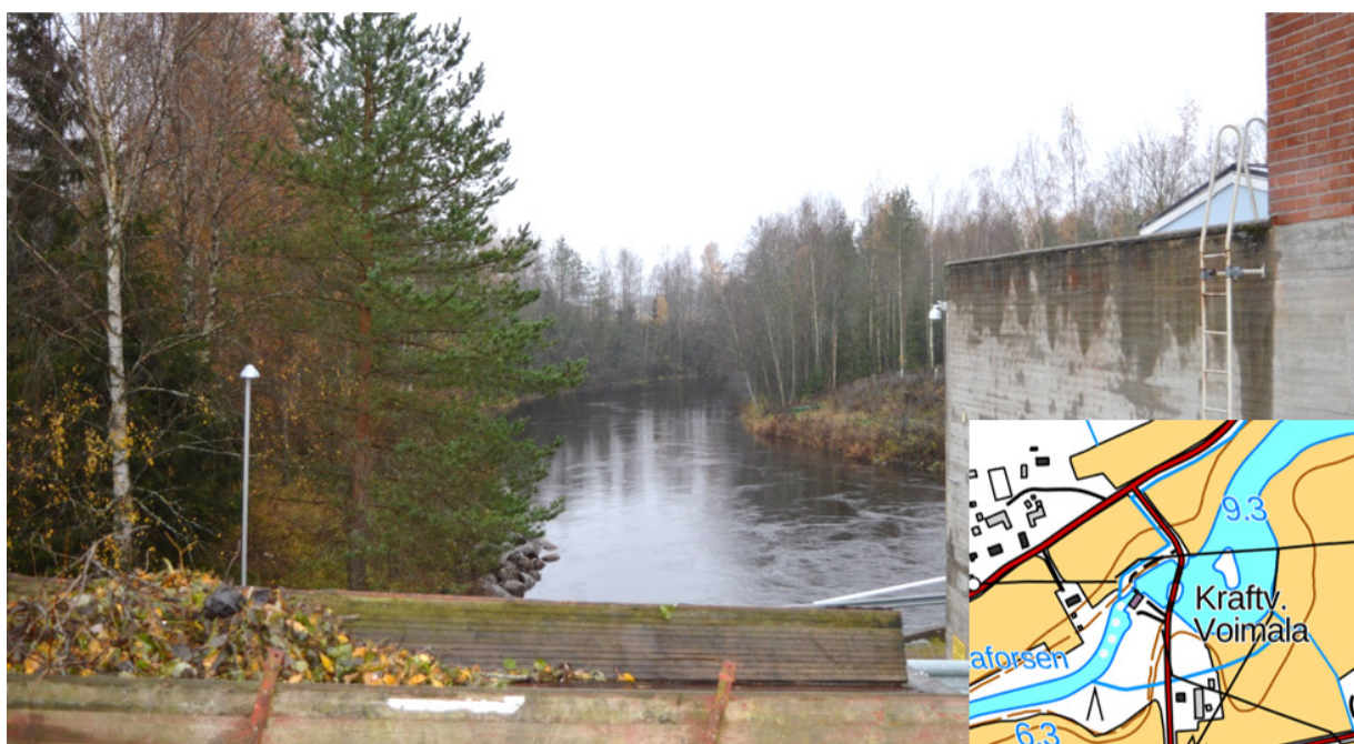
Bild 14. Kraftverket vid Lånaforsen © Lantmäteriverket, Ramboll.
