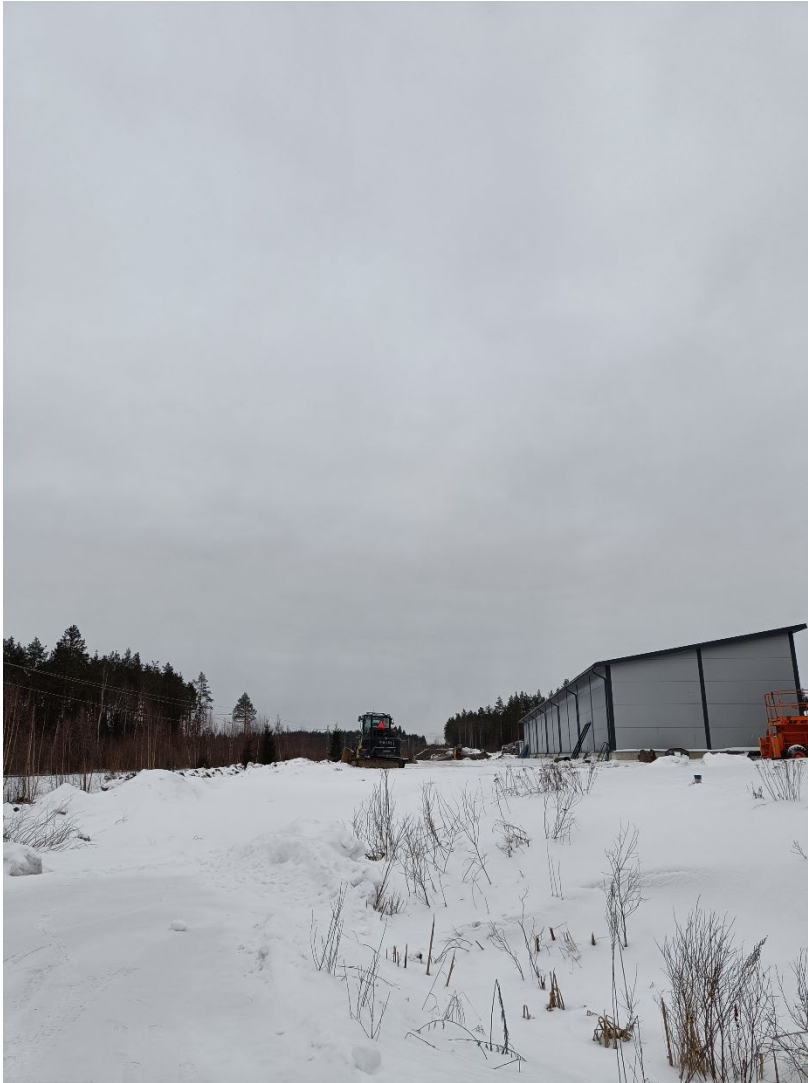
Kuva 6. Ratatietä ei ole rakennettu rautatien viertä pitkin. V-Lifin tontti oikealla puolella.
