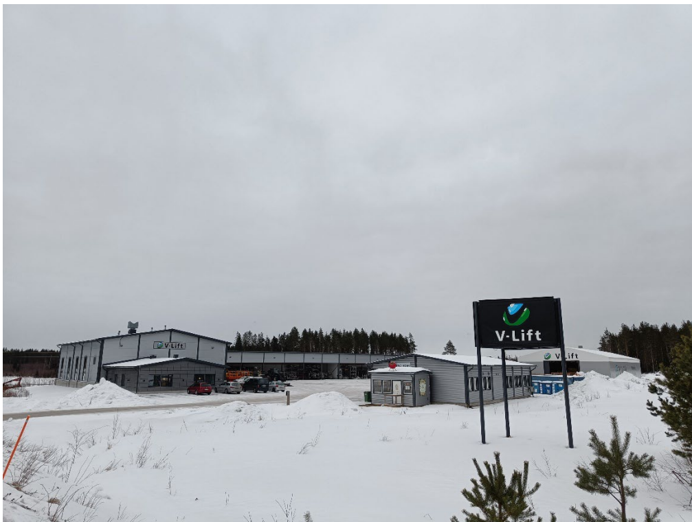
Bild 3. V-Lifts tomt sett från den norra anslutningen från Bennäsvägen till Banvägen.
