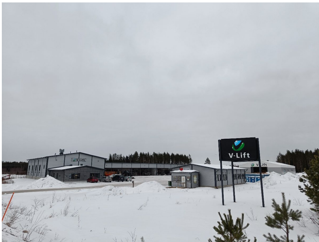
Bild 4. V-Lifts tomt sett från den norra anslutningen från Bennäsvägen till Banvägen.
