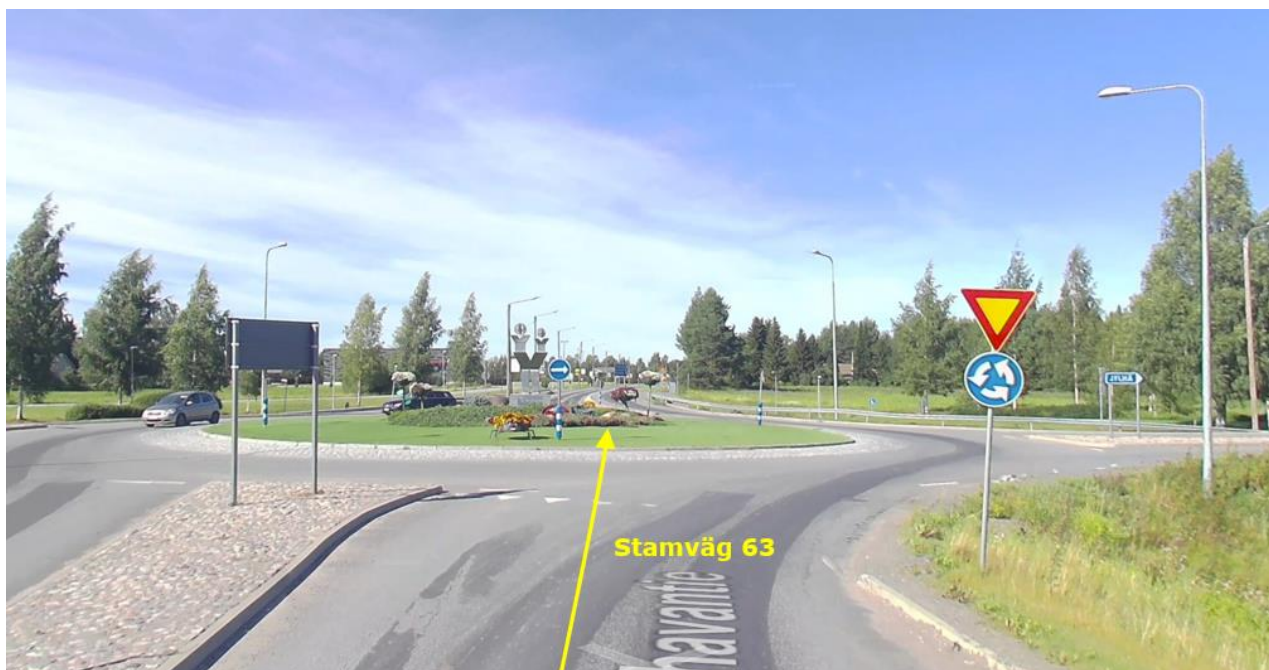
Figur 13: I Kauhava går stamväg 63 genom en rondell. Rondellrefugen måste formas om för att bli överkörbar (Google Maps 2024).
