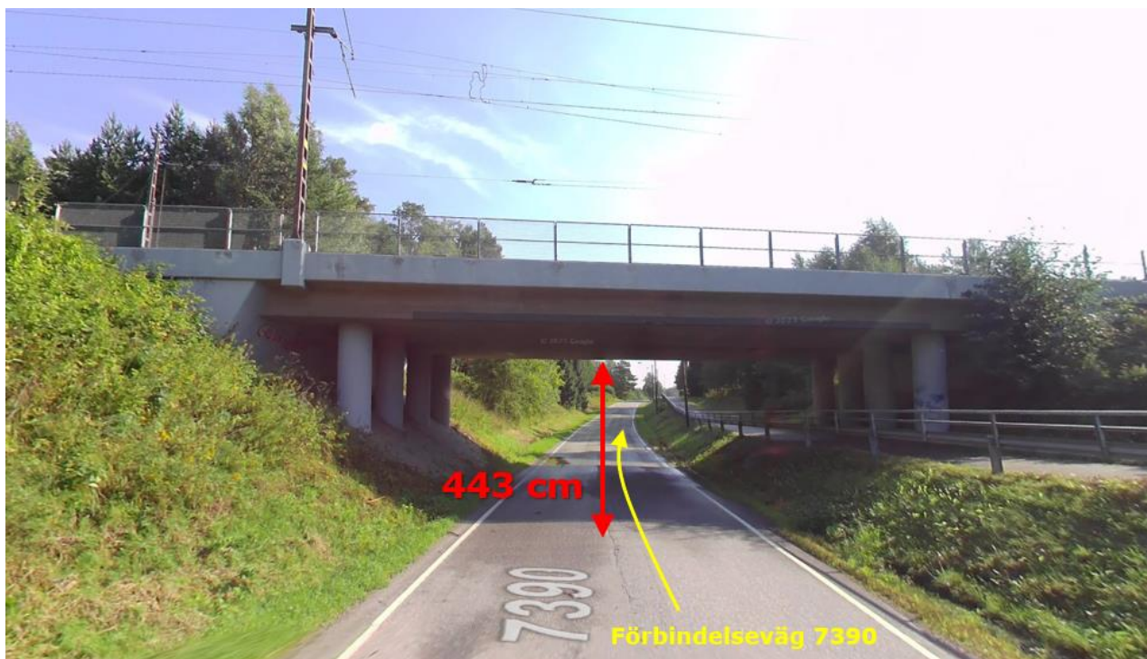
Figur 14: Underfartsbron i Jeppo, i västra ändan av förbindelseväg 7390, begränsar höga specialtransporter till projektområdet västerifrån (Google Maps 2024).
