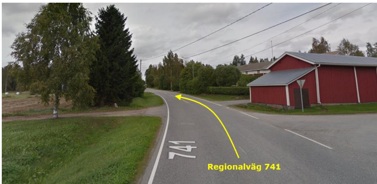
Figur 10: Regionalväg 741 har en krokig geometri. I byn Sandnabba i Pedersöre kommun står byggnaderna nära vägen (Google Maps 2024).
