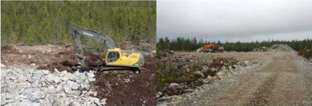
Bild 82. Byggandet av vindkraftsparken inleds med att bygga vägar och service-/resningsområden. (Ville Suorsa, FCG).
