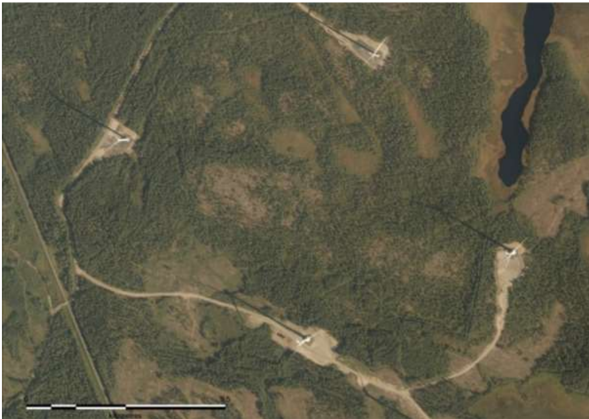
Bild 74. Exempelbild på verksam vindkraftspark. Servicevägar och resningsfält har byggts för vindkraftverken. I omgivningen av vindkraftverken och mellan dem har den tidigare markanvändningen bevarats oförändrad.
