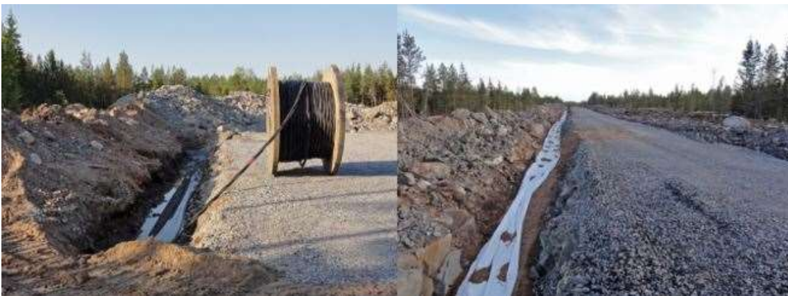
Bild 83. Jordkablarna grävs ner i anslutning till servicevägarna (Ville Suorsa, FCG).
