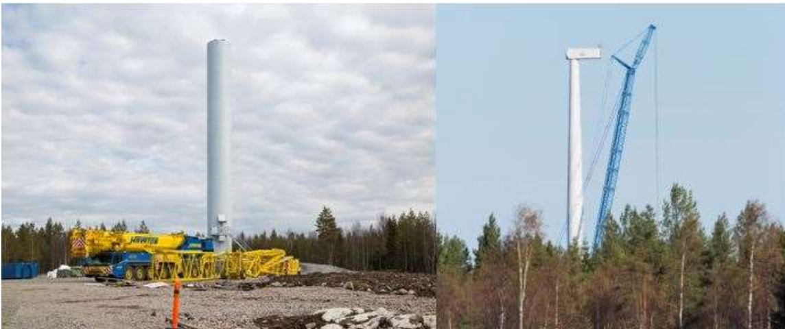
Bild 85. Montering av kraftverk (Ville Suorsa, FCG).
