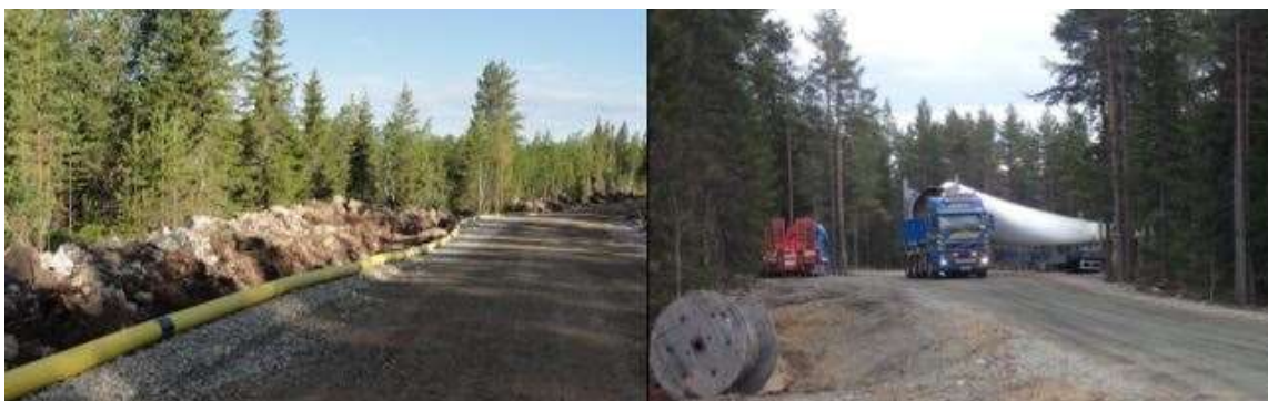
Bild 81. Till vänster ett exempel på byggnads- och servicevägar i vindkraftsparken. Vägarna används bland annat för transport av betong, grus och kraftverkskomponenter samt för servicekörningar i vindkraftsparkens driftsskede. Jordkabeln placeras i ett dikesschakt i kanten av vägen. Till höger delar till vindkraftverk transporteras som specialtransporter. (Ville Suorsa, FCG)
