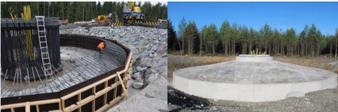
Bild 94. Byggande av grund för vindkraftverk (Leila Väyrynen, FCG).
