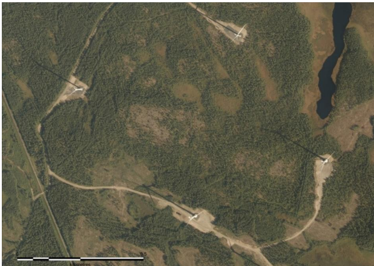
Bild 83. Exempelbild på verksam vindkraftspark. Servicevägar och resningsfält har byggts för vindkraftverken. I omgivningen av vindkraftverken och mellan dem har den tidigare markanvändningen bevarats oförändrad.
