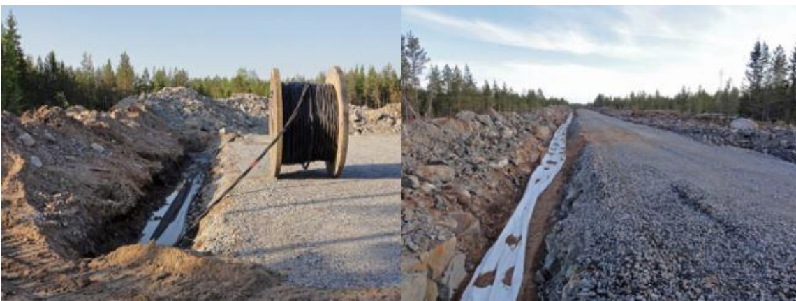
Bild 93. Jordkablarna grävs ner i anslutning till servicevägarna (Ville Suorsa, FCG).
