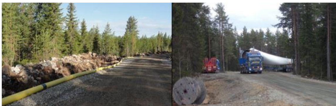
Bild 91. Till vänster ett exempel på byggnads- och servicevägar i vindkraftsparken. Vägarna används bland annat för transport av betong, grus och kraftverkskomponenter samt för servicekörningar i vindkraftsparkens driftsskede. Jordkabeln placeras i ett dikesschakt i kanten av vägen. Till höger delar till vindkraftverk transporteras som specialtransporter. (Ville Suorsa, FCG)
