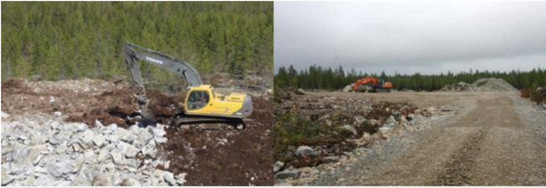
Bild 92. Byggandet av vindkraftsparken inleds med att bygga vägar och service-/resningsområden. (Ville Suorsa, FCG).
