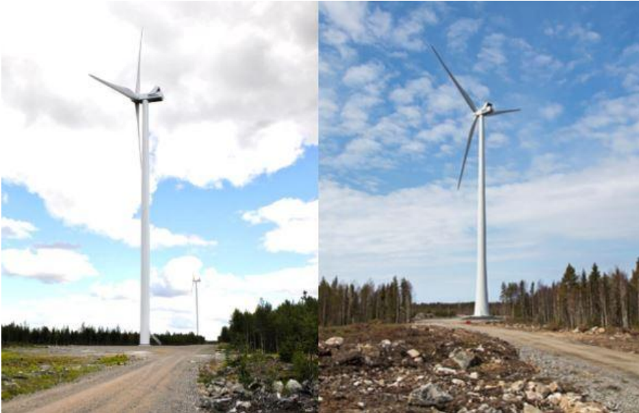
Bild 84. Till vänster ett exempel på ett cylindertorn och till höger ett hybridtorn (Leila Väyrynen och Ville Suorsa, FCG).
