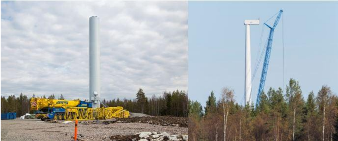
Bild 95. Montering av kraftverk (Ville Suorsa, FCG).
