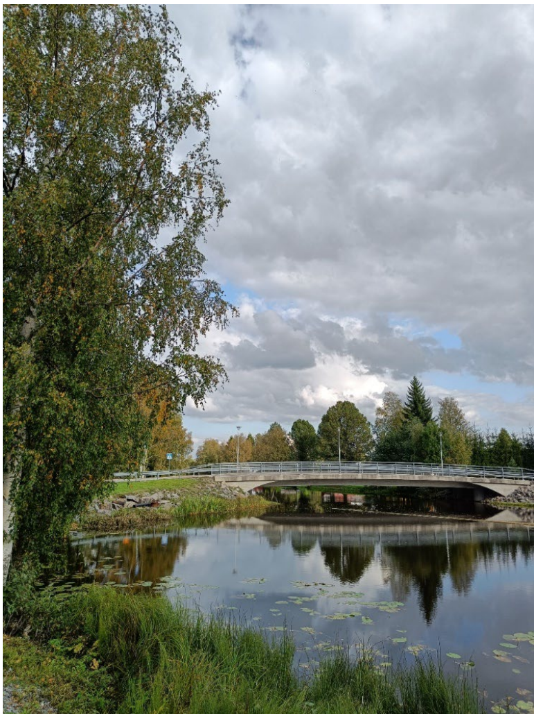
Kuva 4. Keskustie seurailee Ähtävänjokea. Kuvassa näkyy Herrforsin silta Herrforsin voimalaitoksen vieressä.
