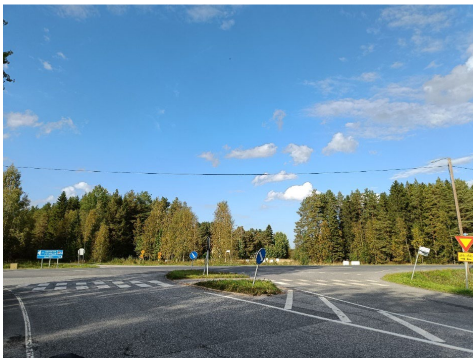
Bild 5. Centrumvägens västra anslutning från Kållbyvägen.
