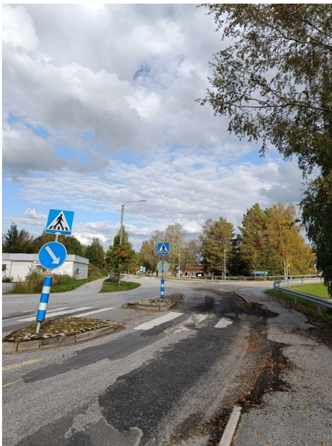
Bild 7. Ställvis är beläggningen väldigt dålig och mittrefugerna försvårar tillgängligheten för tungtrafiken.
