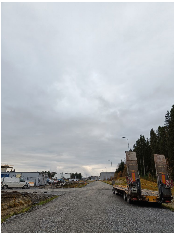
Bild 5. Mush håller på att bygga sin nya fabrik invid Bärholmsvägen.
