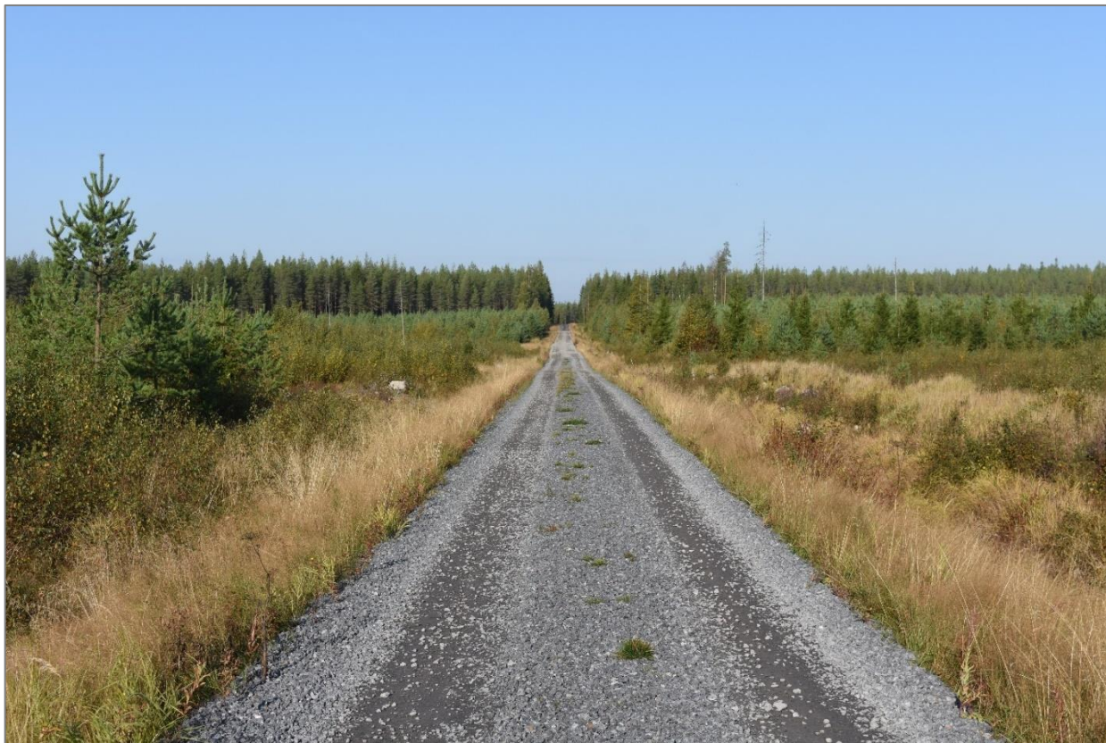
Bild 22. Bild tagen vid Mastbacka skogsbilväg i riktning mot väst i västra delen av projektområdet.
