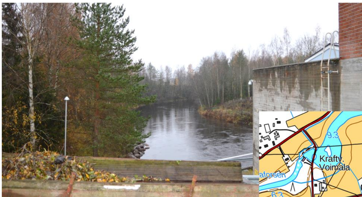
Bild 12. Kraftverket vid Lånaforsen © Lantmäteriverket, Ramboll.
